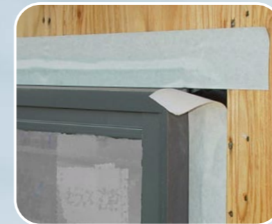
サッシ窓・開口部周り施工例
