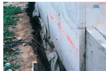
下地の清掃、セパレーターボルト除去
