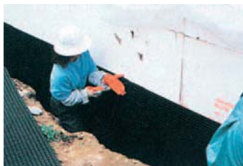
パネル上部を釘・ビスで固定
