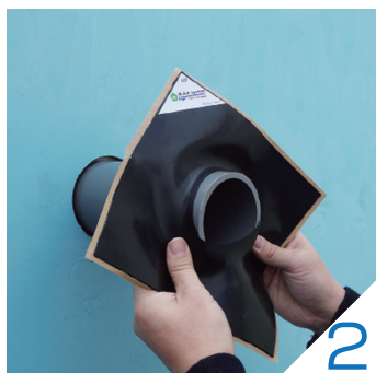
気密パッキンを 配管に通す
