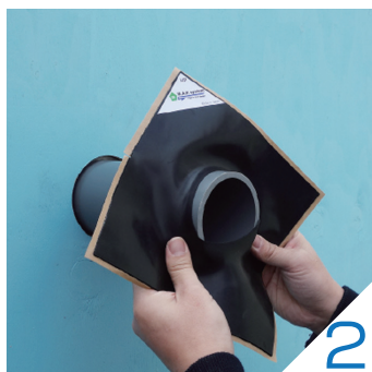
気密パッキンを 配管に通す
