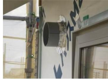
※湿式仕上げの場合、断熱材に直接ビスで取り付けできませんので、当社支給(有償)の外断熱用断熱ピンをお使いください。
